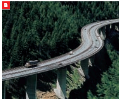
Autostrada in montagna
